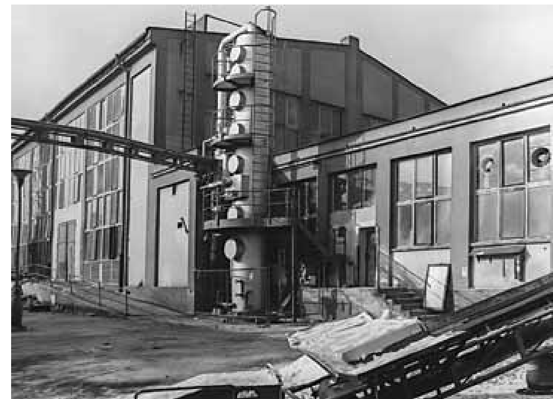
^Hutní hala po rekonstrukci, 70. léta. (Archiv Moser)
