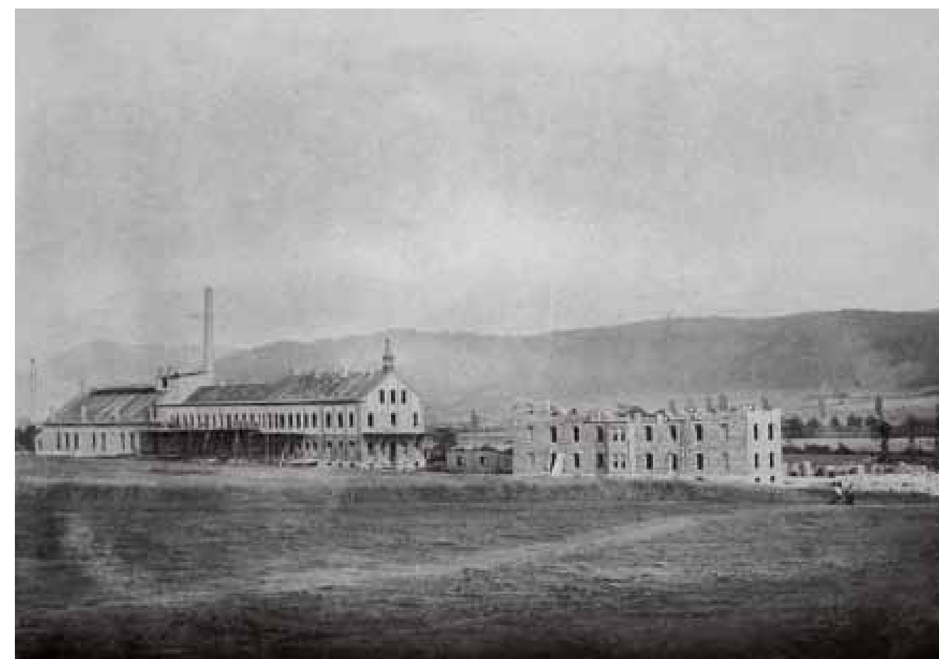
^ Stavba sklárny Ludwiga Mosera ve Dvorech u Karlových Varů, asi 1893. (Archiv Moser)
